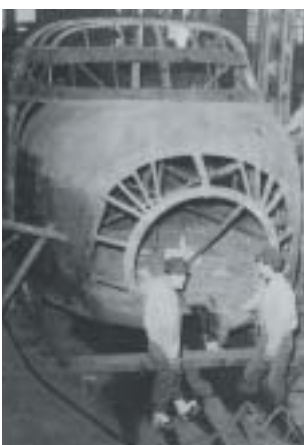
東海道新幹線試乗車両の「顔」 （写真提供：山下工業所）
